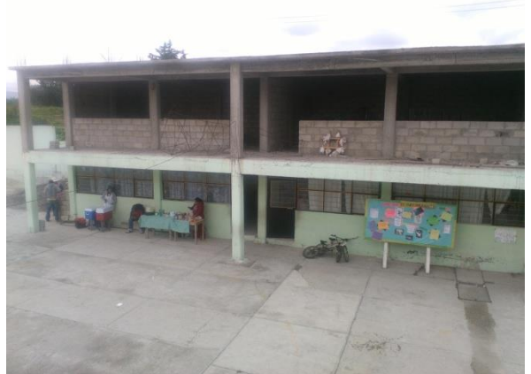
SALONES EN CONSTRUCCIÓN
